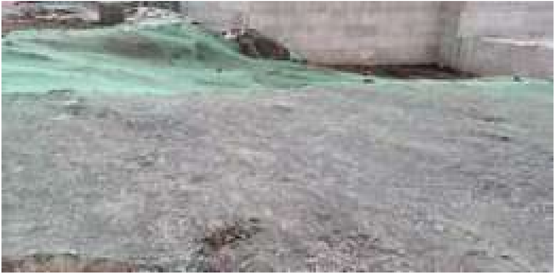
施工期间临时苫盖
