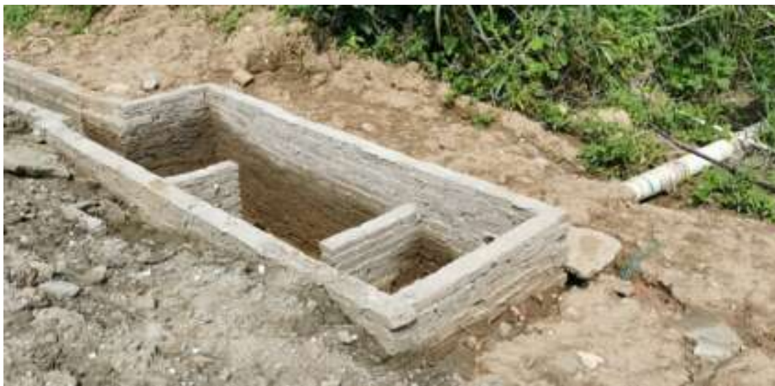
施工期间临时沉沙池
