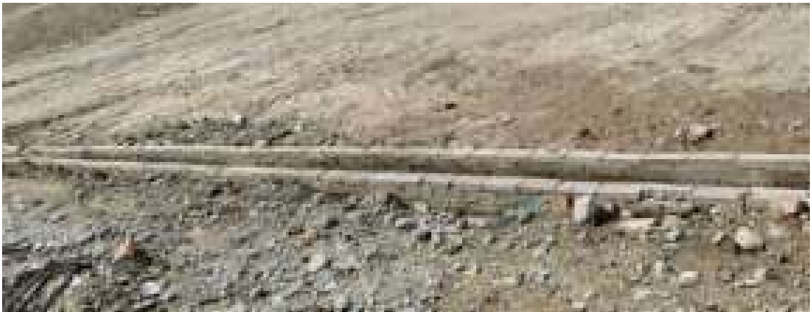
施工期间临时排水沟
